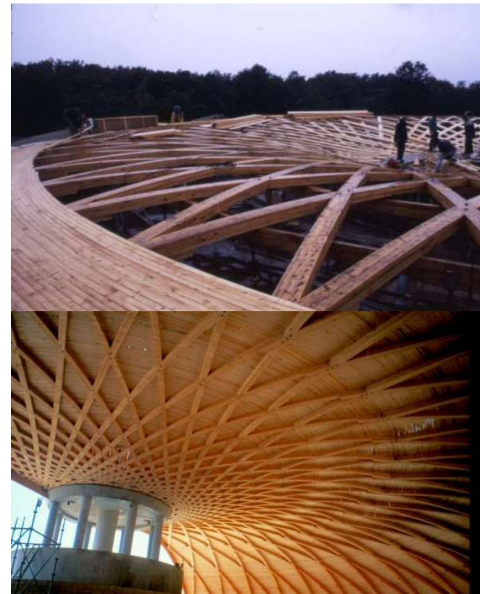
figures 36.3 et 36.4 : réalisation, toiture toroïdale composée d'arcs géodésiques en planches contre-clouées permettant le croisement au droit des noeuds.
